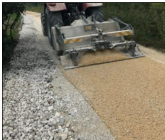
Sistemazione strade campestri con pavimentazione ammalorata
