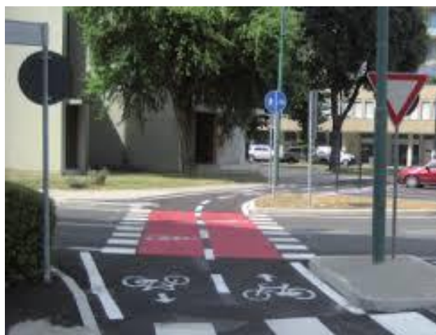
Attraversamenti su intersezioni ciclabili e veicolari
