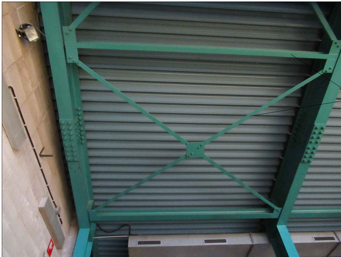
INTERVENTO 1: SPOSTAMENTO ARCARECCI E CONTROVENTI ESISTENTI
